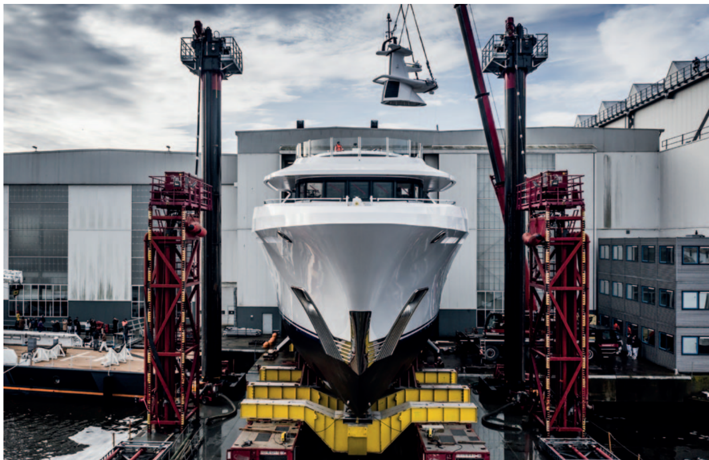
Bij ponton De Schelde worden de vier spudpalen hydraulisch aangedreven door zestien tandwielkasten
